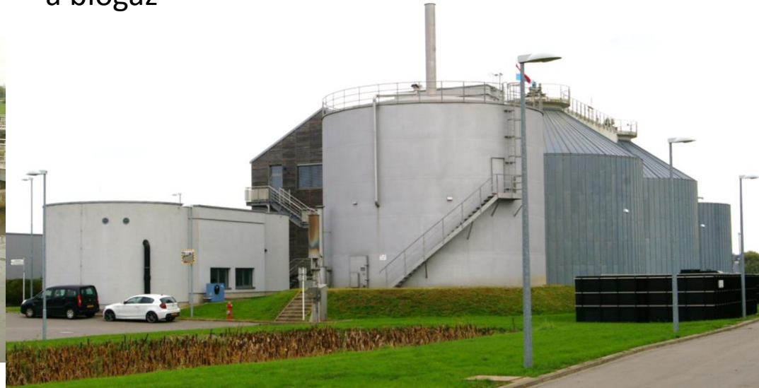
Réservoir à boues, 2 digesteurs et le réservoir à biogaz
