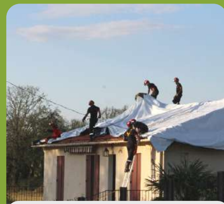
Bâchage des toitures
