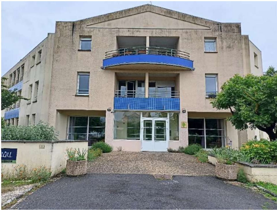
Changement des 2 portes d'entrées en portes automatiques
