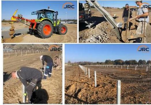
Comme vous pouvez le constater sur les images ci-dessus, le projet ne nécessite aucune artificialisation du sol. Le sol de la serre restera enherbé, aucun béton ne sera mis sur l'entièreté du sol, seul les plots sont fixés au sol (cf. photo n°2 ci-dessus).
