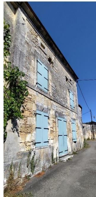
Les travaux portent sur un décrépiage, remplacement de pierres de taille dans les ouvertures et crépis sur finition pierre apparente.
